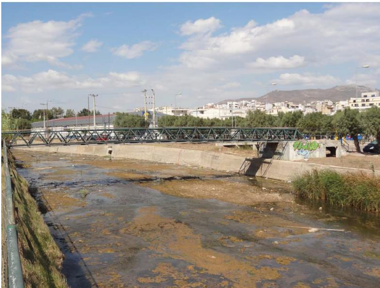
Εικόνα 6.30: Πεζογέφυρα κοντά στην εκβολή του ρ. Ραφήνας – Κατεύθυνση Δυτική [Πηγή: Μελέτη Περιβαλλοντικών Επιπτώσεων Διευθέτησης-Οριοθέτησης Ρέματος Ραφήνας]
