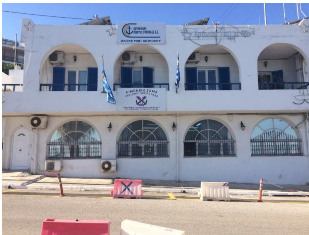
Εικόνα 11.60: Το Λιμεναρχείο Ραφήνας και τα γραφεία του Ο.Λ.Ρ. Α.Ε. στην ΒΔ πλευρά της Ακτής Παπανδρέου
