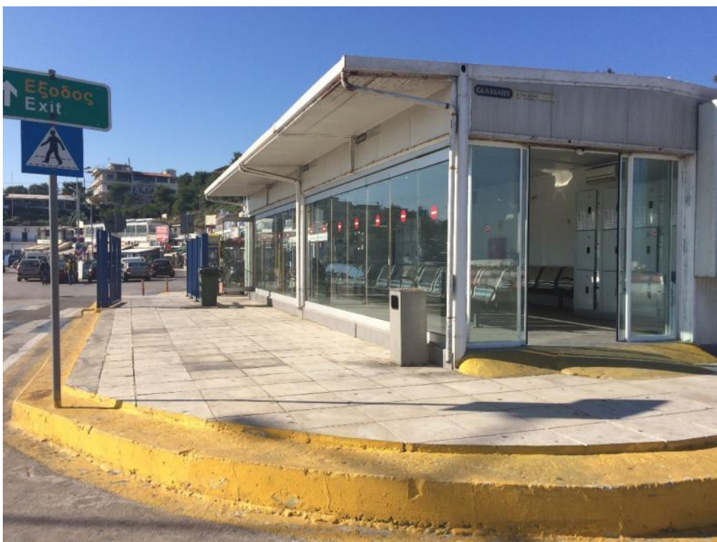
Εικόνα 11.12: Κλιματιζόμενος Χώρος Αναμονής Επιβατών δεξιά της Κεντρικής Εξόδου
