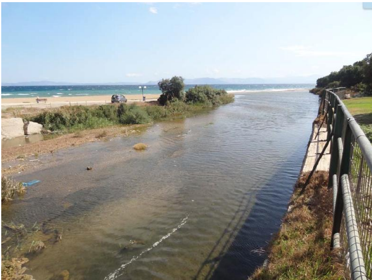
Εικόνα 6.29: Εκβολή ρ. Ραφήνας – Κατεύθυνση Ανατολική [Πηγή: Μελέτη Περιβαλλοντικών Επιπτώσεων Διευθέτησης-Οριοθέτησης Ρέματος Ραφήνας]
