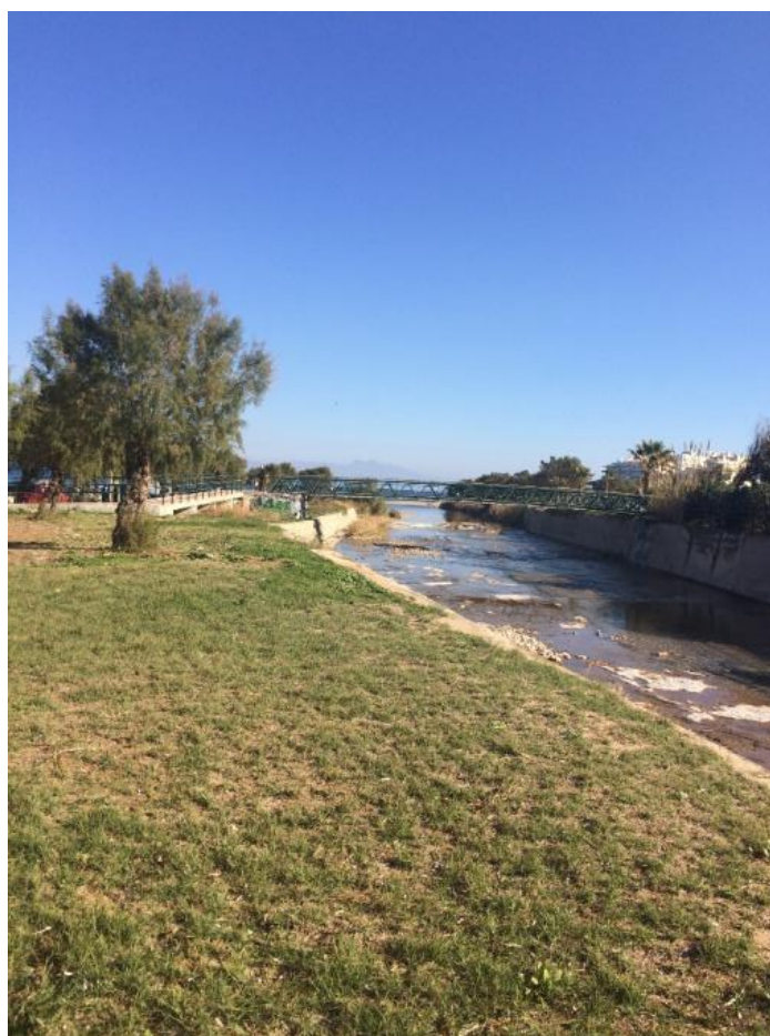
Εικόνα 11.36: Το ρέμα με την γέφυρα στο βάθος
