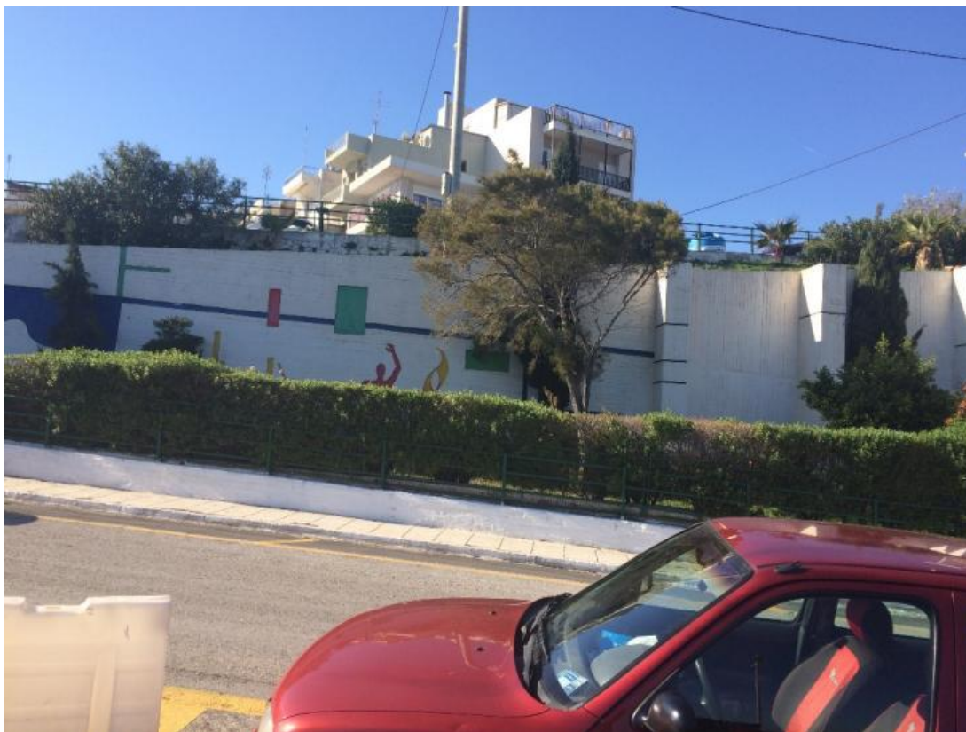
Εικόνα 11.57: Ο τοίχος αντιστήριξης στην ΒΔ πλευρά της Ακτής Παπανδρέου
