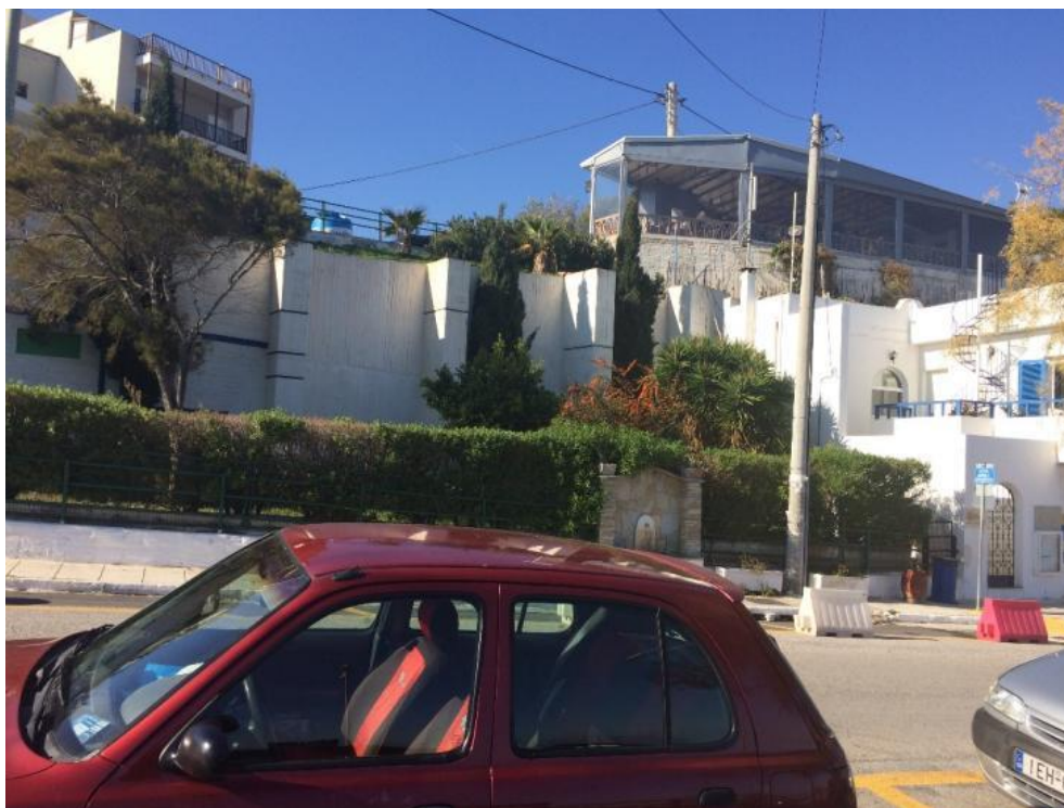
Εικόνα 11.58: Ο τοίχος αντιστήριξης της ΒΔ πλευράς της Ακτής Παπανδρέου
