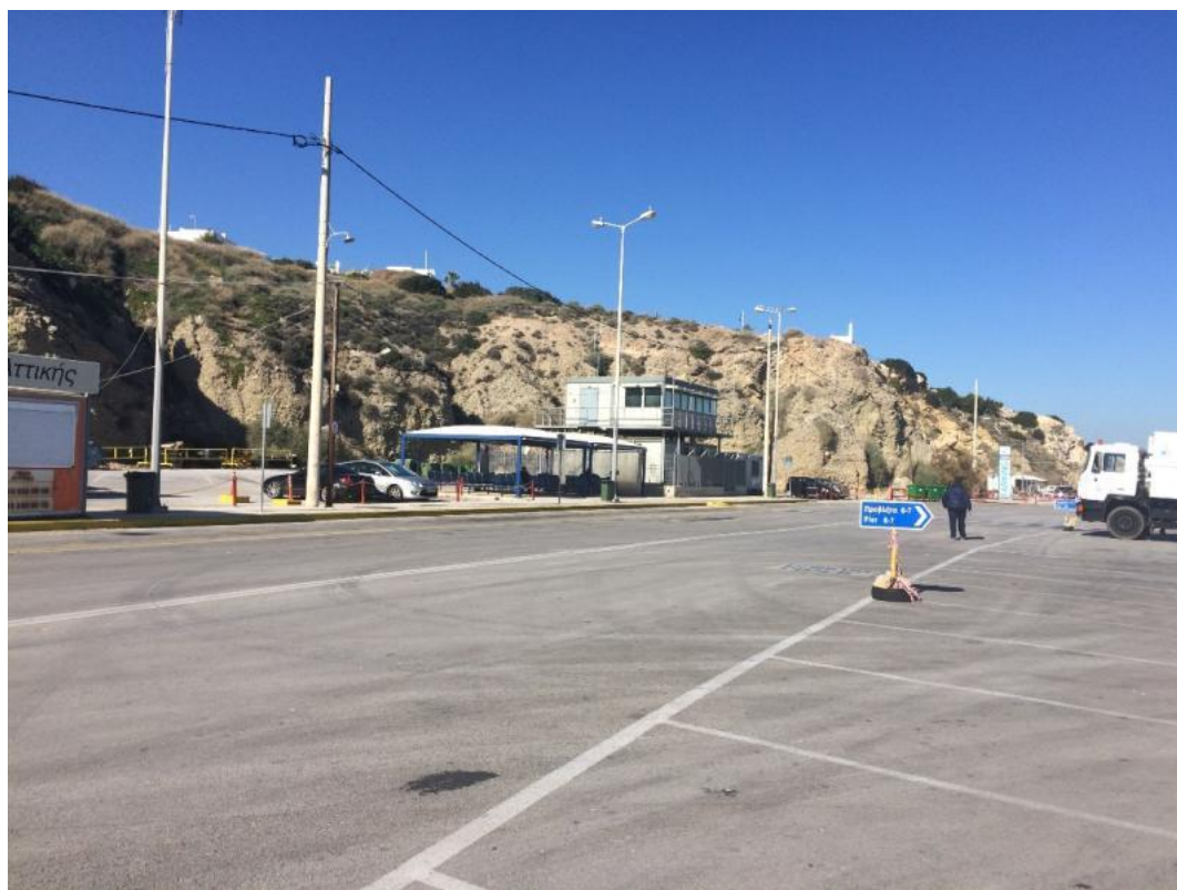
Εικόνα 11.8: Στέγαστρο στάσης Λεωφορείων και Κτίριο Κέντρου VTS
